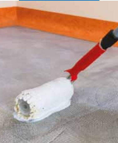
Eco Prim T bedolgozása hengerrel
