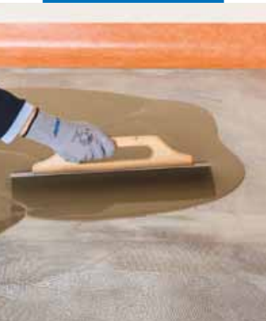
Ultraplan Fast Track bedolgozása fém simítóval
