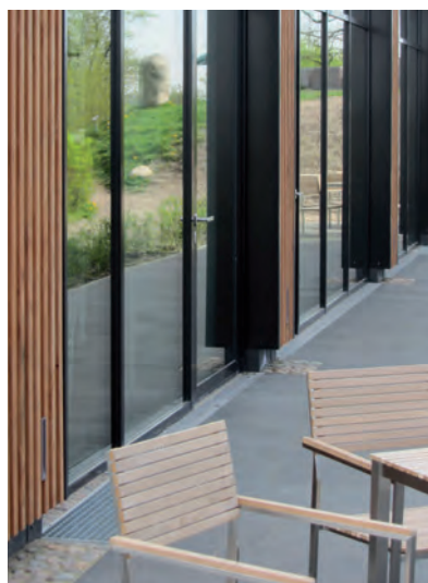
Zárt fuga esetén a csőhálózathoz csatlakoztatva: ACO Self® Euroline-nal
