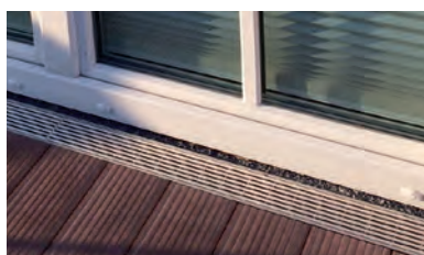
Nyitott fuga esetén csőcsatlakozás nélkül: ACO Self® Highline-nal
