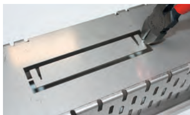
A folyókacsatlakozó/retesz tartozékként is kapható és a folyótest aljába integrálva is megtalálható.
