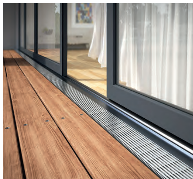
Homlokzat és bejárat - dizájn rácsokkal
