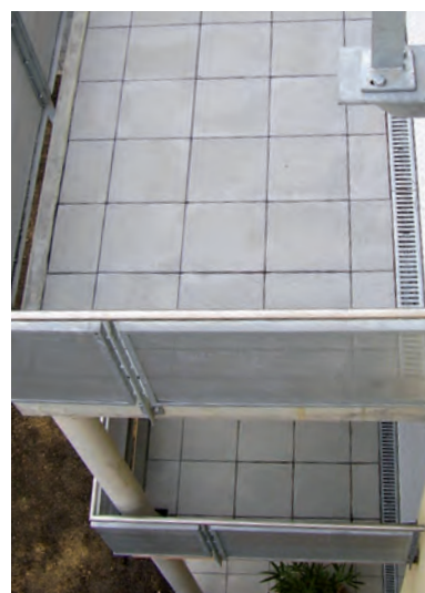
Nyitott fuga esetén csőcsatlakozással: ACO Self® Highline-nal
