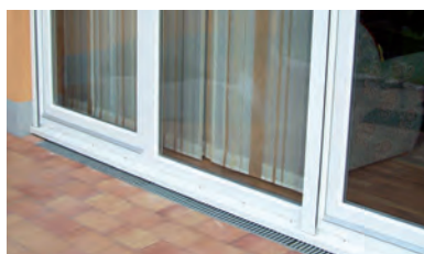
Zárt fuga esetén a drain rendszerhez csatlakoztatva: ACO Self® Hexaline-nal
