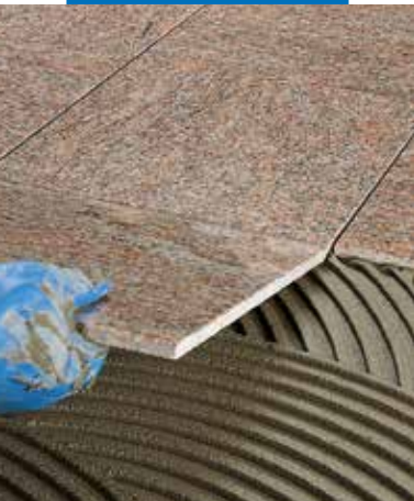
Polírozott márvány burkolólap ragasztása padlóra
