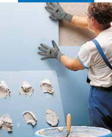
Habosított polisztirol táblák ragasztása fehér Keraflex-szel
