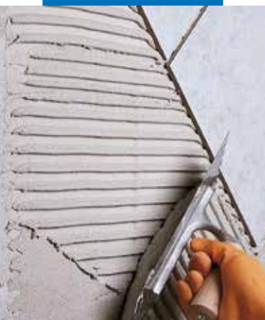
Egyszer égetett burkolólap ragasztása gázbeton falra
