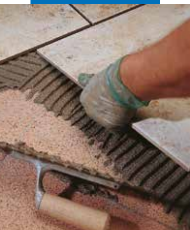
Egyszer égetett burkolólap ragasztása terrazzo burkolatra kültéri falon
