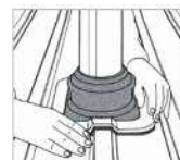
4. A Dektite-t pontosan formálja rá a profillemmeze.
