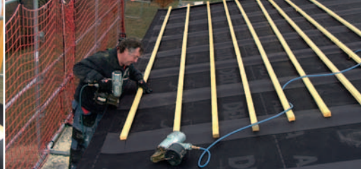
Cseréplécek gyors elhelyezése.
