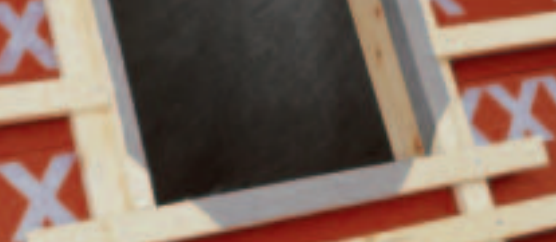
Részletképzés tetősíklablak beépítésénél.
