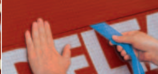
Védőfóliát lehúzni. Átlapolást összenyomni. Kész.
