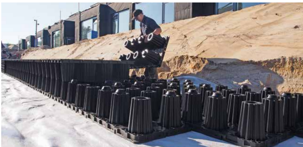
A rendszer félelemek (alapelem) összepattintásával alakítható ki
