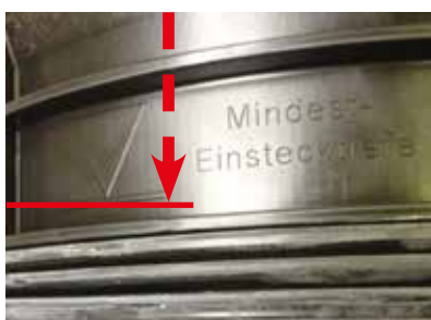
Állítsuk be a minimum mélységet!
