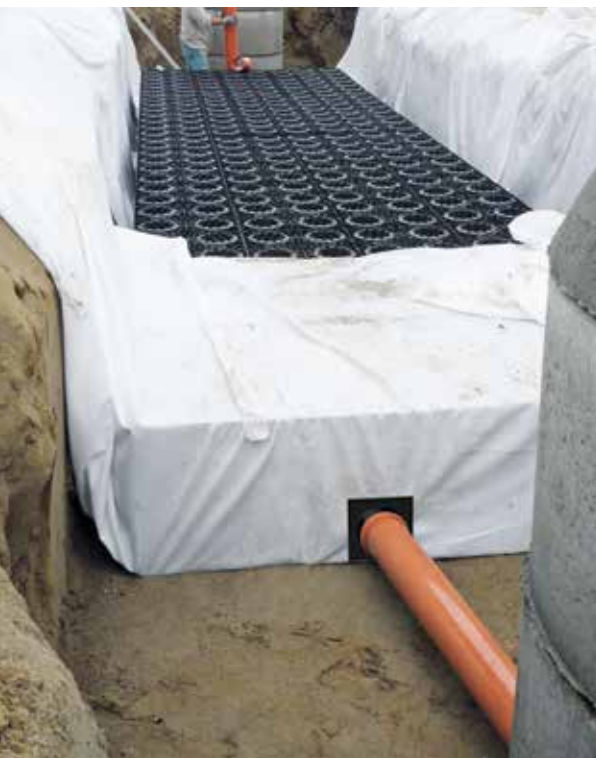
A geotextília teljesen körbe burkolja a szikkasztó rendszert
