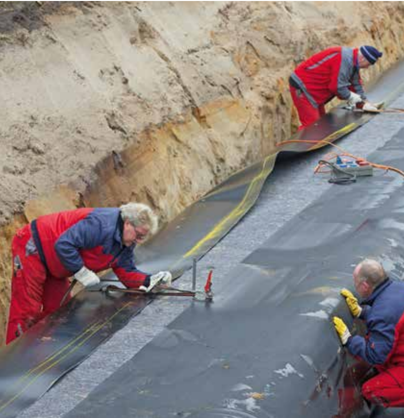
A tározó tartály külső és belső geotextíliával és vízzáró fóliával kerül leburkolásra
