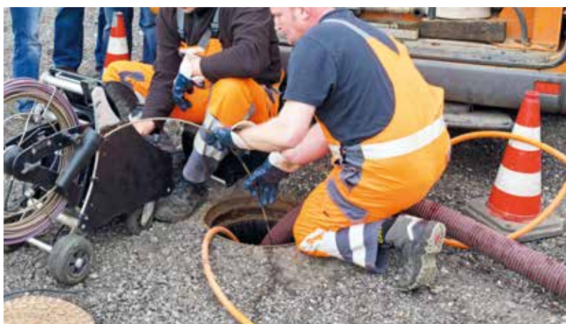
A megfigyelő rendszer és tisztító egység egyszerűen és akadálymentesen vezethető a rendszerbe a fedlapon keresztül
