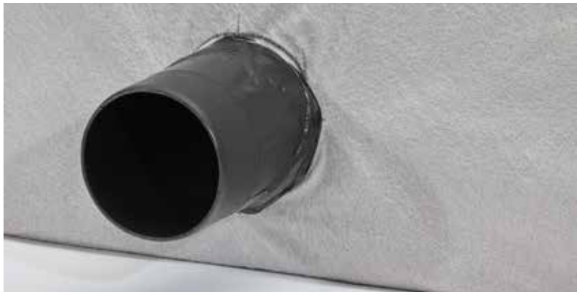
A geotextília rögzítése a csőcsatlakozáshoz
