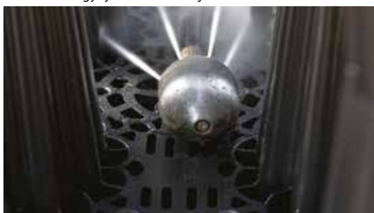
Kamera és nagynyomású mosófej bevezetése
