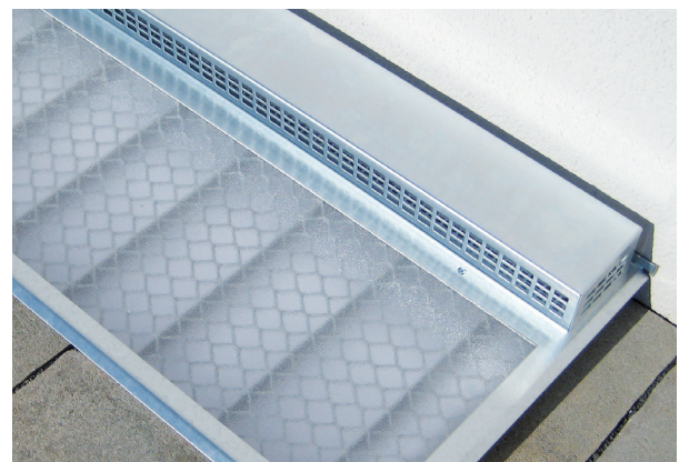
aknafedél szellőzőrekeszrel
