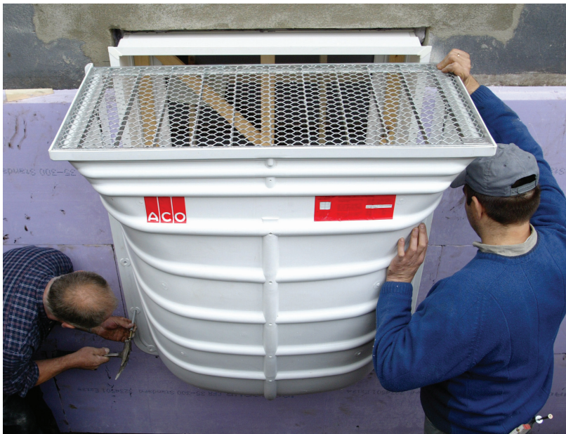
ACO Világítóakna polipropilénből, merevítő bordázattal
