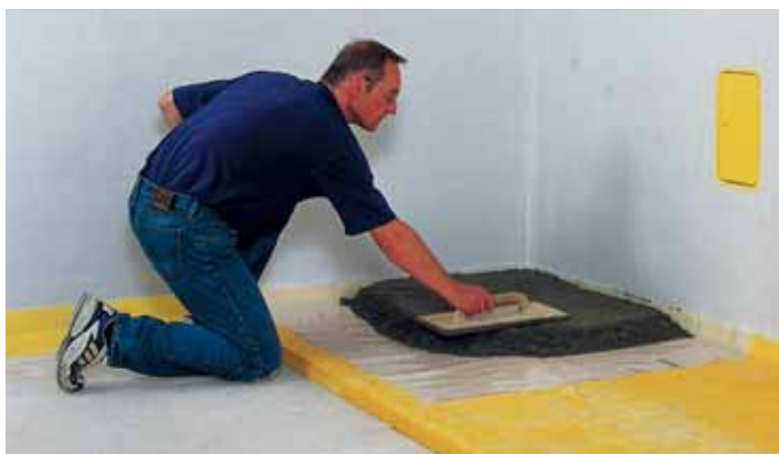
Úsztatott padló szerkezet
